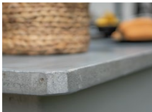
Med en vinkelslip med sliptrissa kan du anpassa hörn och kanter så att du får önskat resultat.
