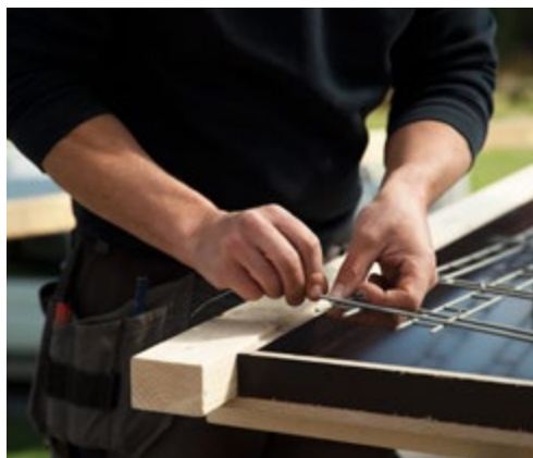
Häng upp armeringen med najtråd så att den hänger fritt i formen.
