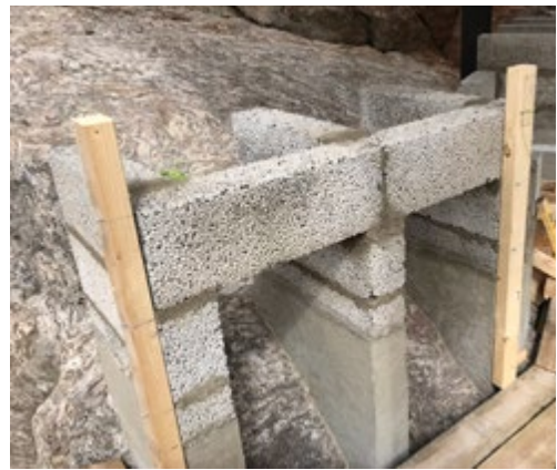
Säkerställ att blocken ligger i lod och i våg.
