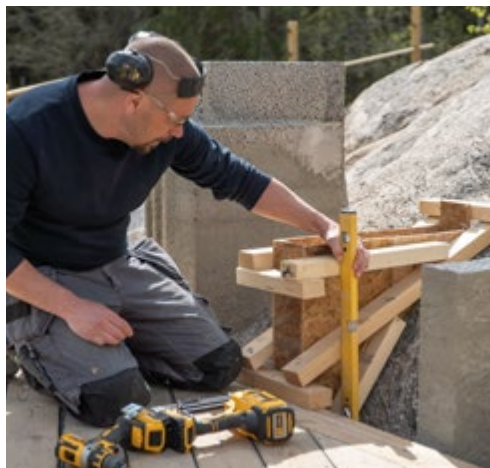
Socklarnas bredd ska vara lika med bredden på de block du väljer att mura med.
