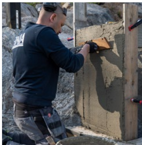
Avdragsbanorna hjälper dig att få ett jämntjockt puts-lager.
