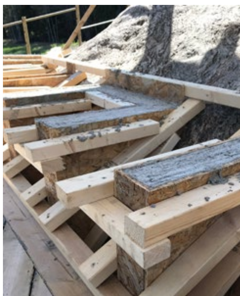
För att murbruket ska fästa bättre vid murning ska ovansidan på sockeln vara grov.
