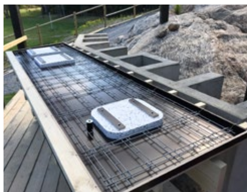
Lägg formen på ett bord bredvid köket innan du gjuter. Detta för att slippa onödiga lyft vid avformning.
