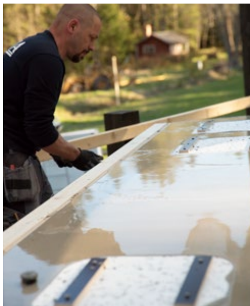
Slå försiktigt ut eventuella luftbubblor för ett slätare och snyggare slutresultat.
